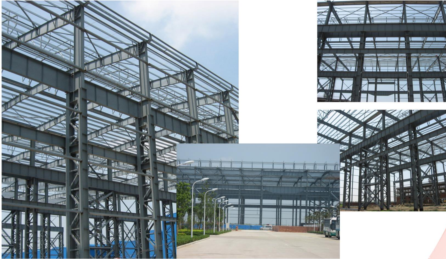
南通振华港机大件车间 2010年10月承建
