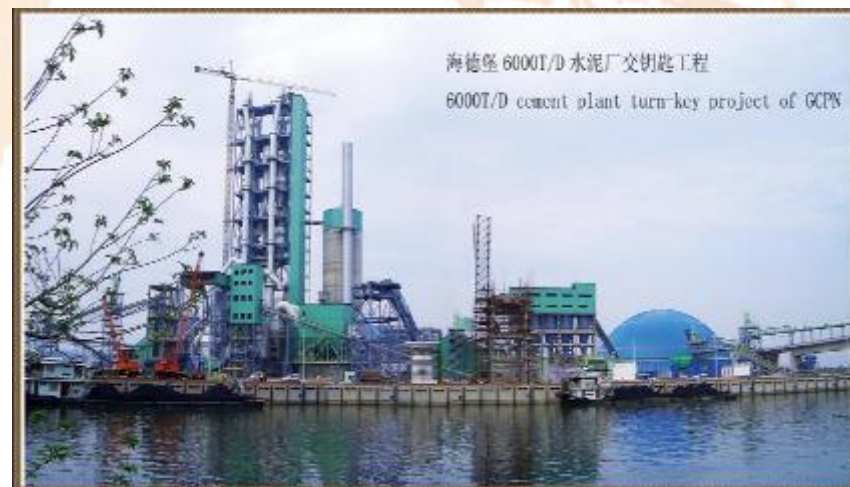
Cimenterie de 6000t/j de Heidelberg à Guangzhou
