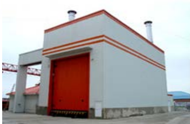
Grand Four de Traitement Thermique
