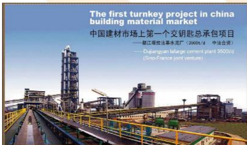
Cimenterie de 3500t/j de Lafarge à Dujiangyan
