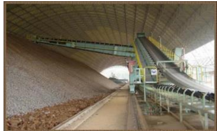
Stockage de Prémélange
