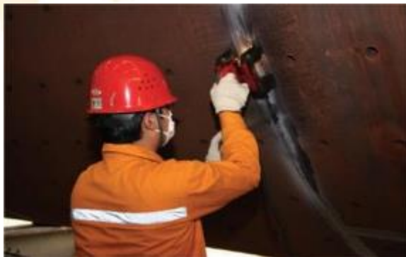
Inspection de Particules Magnétiques
