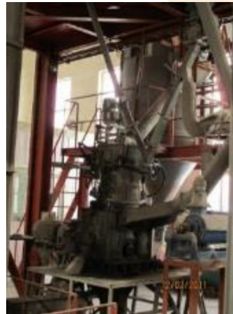
Lit de Test du Broyeur Vertical des Matières Premières
