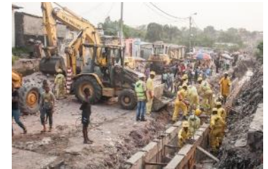
PENDANT LES TRAVAUX
